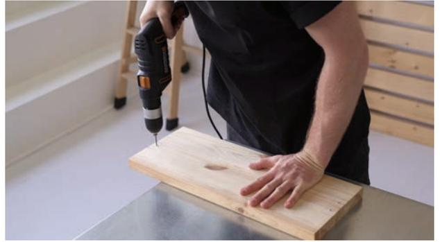
5 | Perfora un orificio de 1,9 cm en la marca de 22 cm y un orificio de 1,2 cm en la marca de 42 cm en ambos soportes de madera.
